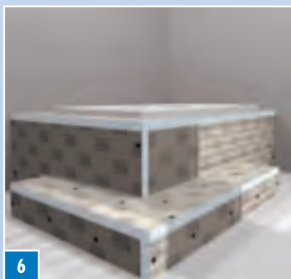
6 Os degraus não necessitam de atravessar até à parede. Deixar secar depois da colagem.
