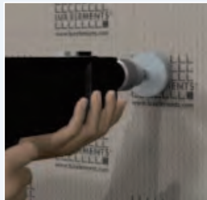
Abriu um furo no painel ELEMENT com uma broca de coroa.
