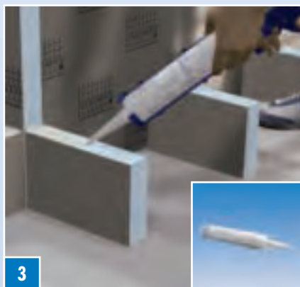
3 Aplicar COL-MK no bordo superior e no bordo lateral isolados dos elementos de apoio. Neste caso, prestar atenção para que a aplicação seja em forma de serpentina/zig-zag.
