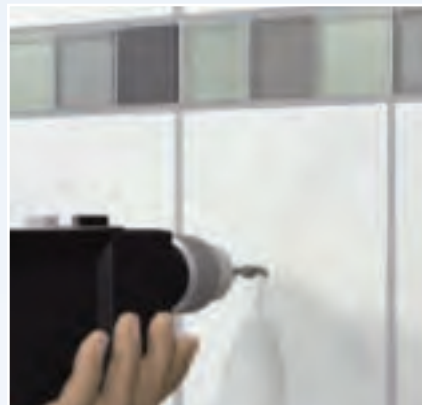
Perfurar o azulejo para utilização de uma bucha de espaço aço.
