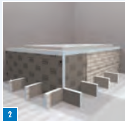
2 Cortar apoios com o mesmo tamanho do restante material, como base para o degrau (≥ EL-30). Colar com COL-MK no chão e no lado exterior da banheira com distâncias regulares (aprox. 30 cm).
