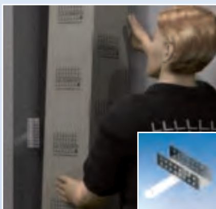
LUX ELEMENTS®-MONT-U p. ex., montagem de coretes na parede
