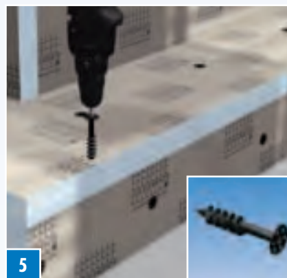
5 Fixar adicionalmente a parte superior e a parte lateral dos degraus com FIX-SD 80.
