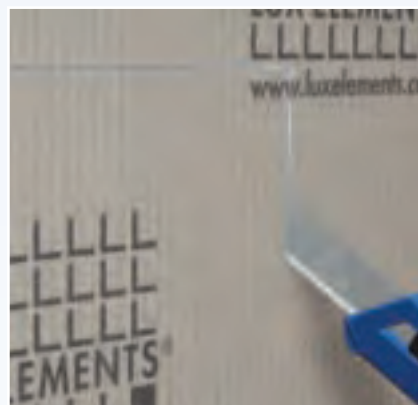
Cortar em paralelo o material de suporte em espuma dura. Em função do tamanho e comprimento dos elementos de suporte em espuma dura, para fender pode ser usada uma faca ou uma rebarbadora (Flex) com disco de diamante. Remover a espuma dura com uma ferramenta adequada (p. ex., chave de parafusos ou escova de arame) tanto quanto for necessário, assentar e aplicar COL-AK com a espátula.
