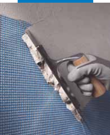
Applicazione del secondo strato di Planitop 207 con interposta Mapenet 150
