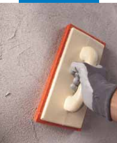
Frattazzatura di Planitop 207
