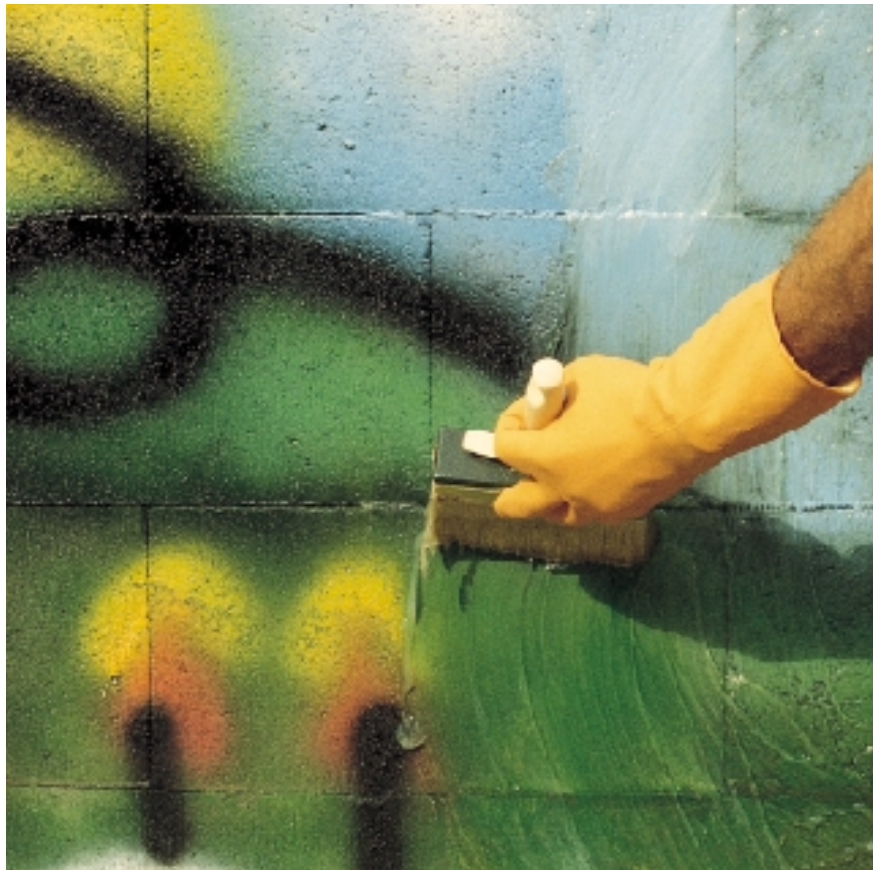
Aplicação de WallGard GRAFFITI REMOVER GEL com pincel
