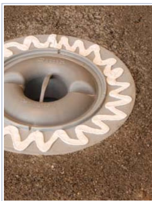
6 aplicar o polímero de MS em forma de zig-zag na superfície da flange.
