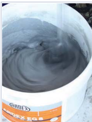
9 verter o componente B sobre o A no recipiente e mexer até obter uma mistura homogênia (ver ficha técnica).
