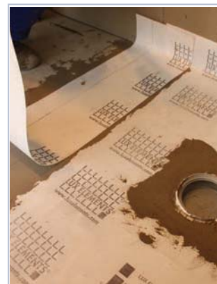
16 aplicar argamassa EG 8 na transição e na restante área, aplicando de seguida a lâmina necessária.
