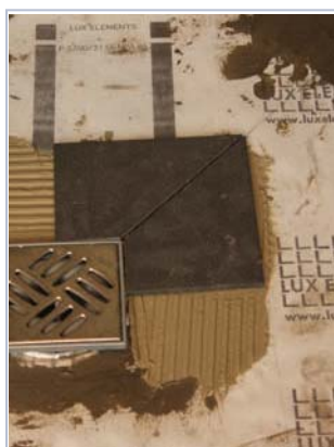
19 preparar a aplicação do revestimento.
