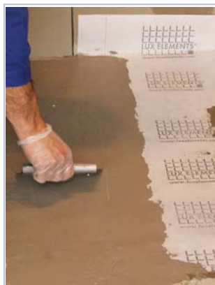
15 preparar lâmina para continuação/sobreposição quando necessário, (em largura superior a 80 cm)
