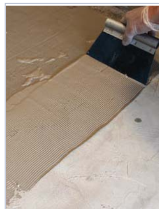
12 aplicar argamassa DRY-ASK sobre toda a área a impermeabilizar.
