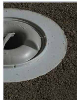
4 exemplo da betonilha à face da flange.
