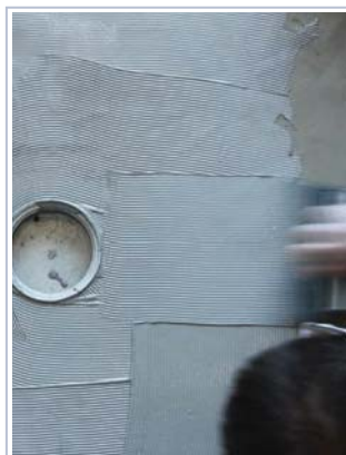
10 aplique a argamassa UP EG 8 sobre a área do centro de impermeabilização 50x50 cm.
