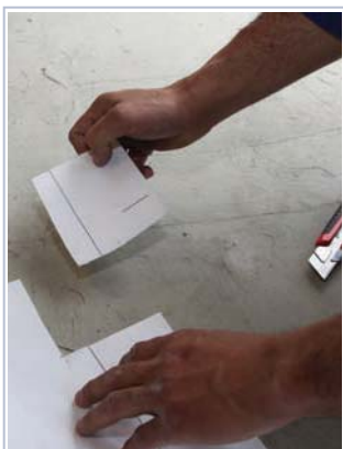
9 preparar a lâmina de impermeabilização, cortar o ângulos 10*10 cm
