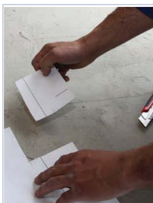
6 preparar a lâmina de impermeabilização, cortar o ângulos 10*10 cm
