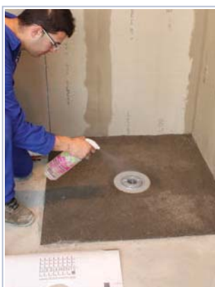
5 limpar e desengordurar a superfície da flange, recomendadoalcool isopropílico.
