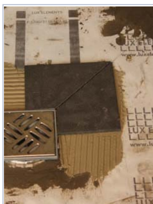
19 preparar a aplicação do revestimento.
