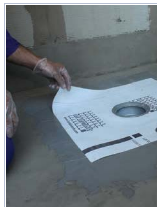
11 aplique seguidamente o centro de impermeabilização fazendo um boa pressão na zona da flange da caixa sifonada.
