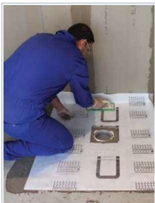
13 aplicar a lâmina DRY-DF sobre a argamassa e apertar com ajuda de uma espátula.
