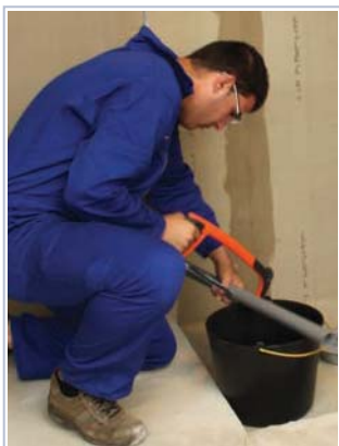
1 preparar a instalação da caixa sifonada ao tudo de esgoto.
