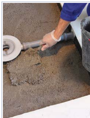
2 colocar a caixa sifonada no local definido, nivelado, com pendente para evacuação da água.
