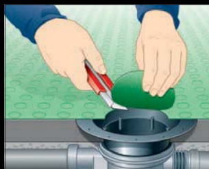
Corte de abertura de drenagem.
