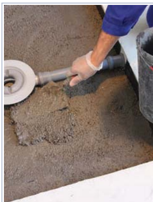
2 colocar a caixa sifonada no local definido, nivelado, com pendente para evacuação da água.
