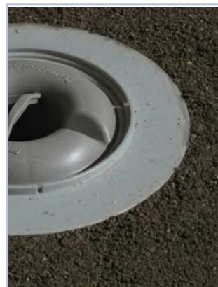
4 exemplo da betonilha à face da flange.
