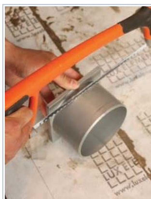
18 cortar o excedente da grelha.
