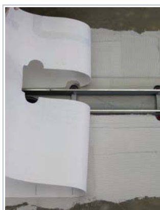
22 exemplo de aplicação do centro de impermeabilização LINEA SUPER G 60 mantendo-se todos os passos de 1 a 19
