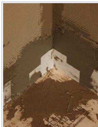
14 ajuste a lâmina na subida da parede (mínimo 10 cm) e aplicar os ângulos vulcanizados.
