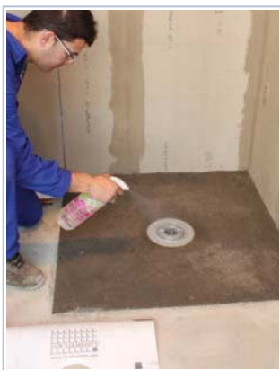
5 limpar e desengordurar a superfície da flange, recomendado álcool isopropílico.
