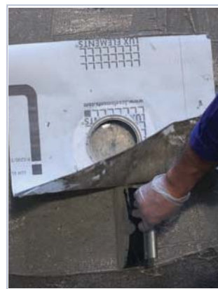
8 passado no mínimo 24 horas, colar o centro de impermeabilização à betonilha com argamassa DRY-ASK
