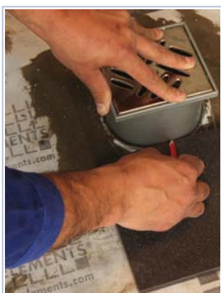
17 marcar a altura de corte da grelha.
