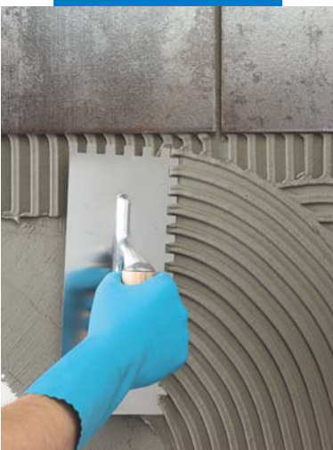
Aplicação de Ultralite S1 com espátula dentada em parede
