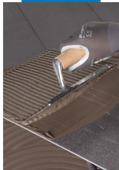
Aplicação do adesivo no reverso do ladrilho
