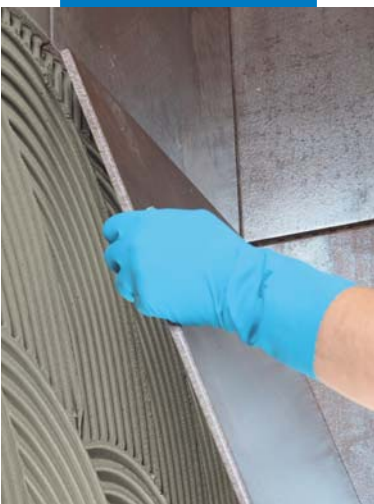
Aplicação de ladrilhos cerâmicos de grande formato em parede
