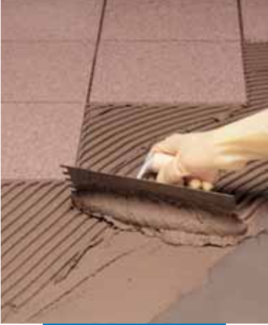
Ejemplo de colocación de gres porcelánico sobre Mapelastíc con Ultraflex S2 Quick
