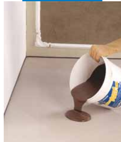
Versamento dell'adesivo sul massetto
