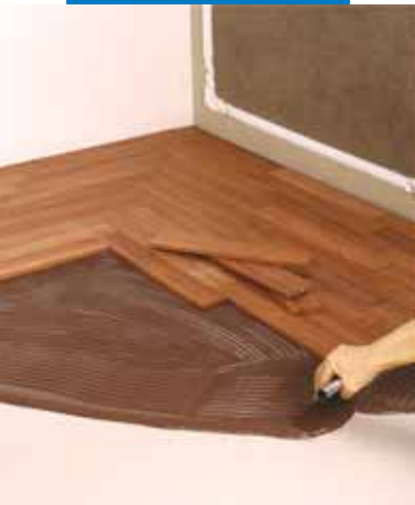
Stesura dell'adesivo con spatola dentata da legno
