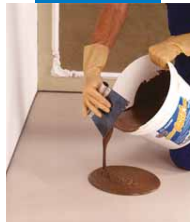
Sbavatura dell'adesivo con la spatola
