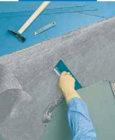
Espalhamento de Ultrabond Eco V4 Conduttivo
