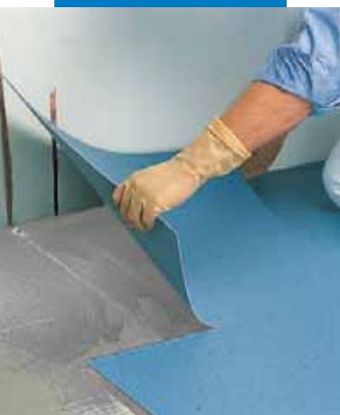
Aplicação de quadrados em PVC condutivo com Ultrabond Eco V4 Conduttivo
