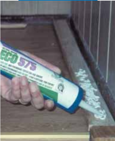
Encolado de zócalos de madera con Ultrabond Eco 575
