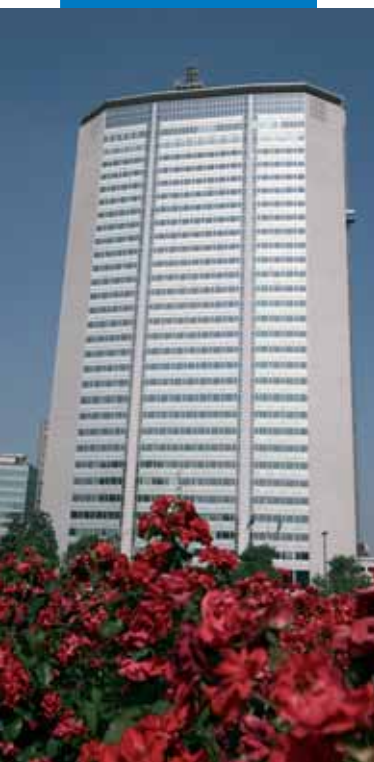
Aplicação de linóleo em mosaicos sobre cortiça - Edifício Pirelli - Itália
