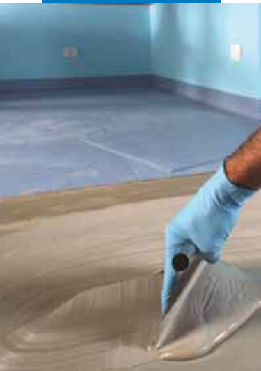
Stesura di Ultrabond Eco 380
