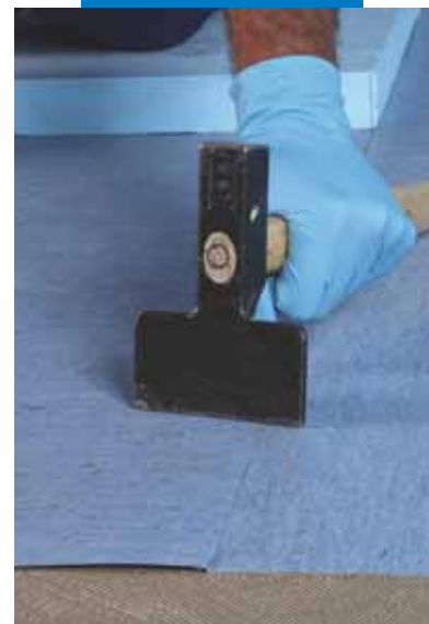
Massaggiatura delle quadrotte in PVC
