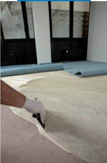
Stesura di Ultrabond Eco 170
