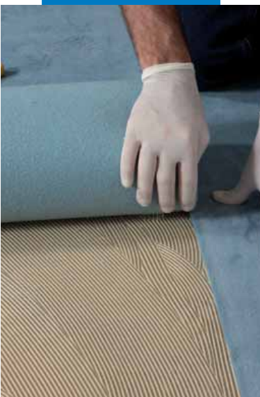
Posa in opera dei teli di moquette
