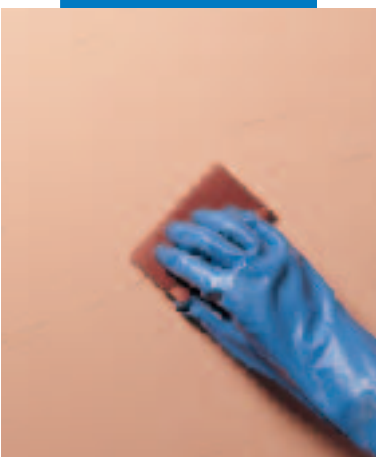
Effetto classico: carteggiatura della prima mano di Silexcolor Marmorino con carta abrasiva fine
