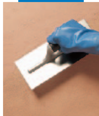
Effetto encausto: applicazione Silexcolor Marmorino su Silexcolor Tonachino
