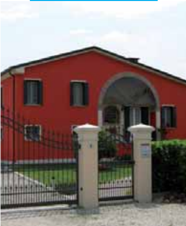
Esempio di edificio trattato con Silancolor Tonachino Plus
