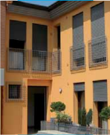
Particolare interno di abitazione residenziale realizzata con Quarzolite Tonachino Plus
