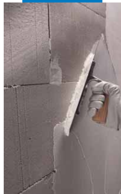
Rasatura della parete in blocchi con Porocol FF
