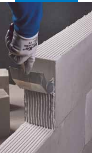
Stesura di Porocol FF sulla parete verticale dei blocchi
