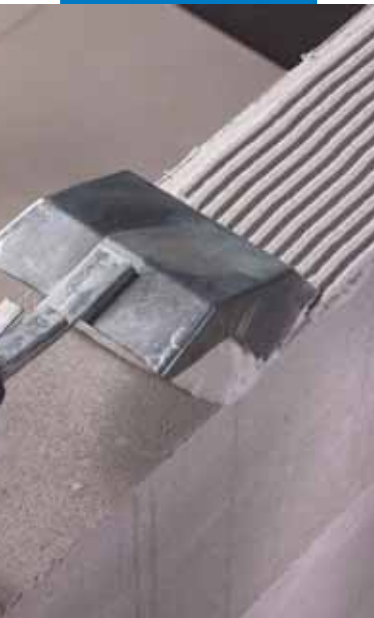
Stesura di Porocol FF sullo spessore della parete con speciale cazzuola dentata
