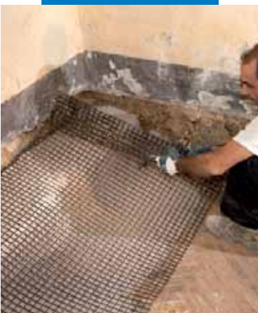
Posizionamento della rete di rinforzo in fibra di vetro alcali-resistente Mapegrid G 220
