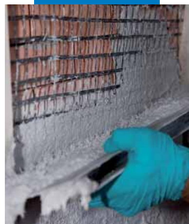
Applicazione del sistema Planitop HDM Restauro e Mapegrid G 220 su parete in muratura
