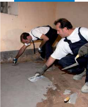
Posa del primo strato a spatola di Planitop HDM Restauro all'estradosso di una volta
