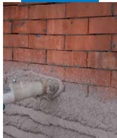
Applicazione a spruzzo di Planitop HDM Restauro su parete in muratura
