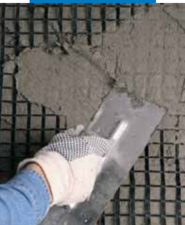
Colocación de Mapegrid G 220
