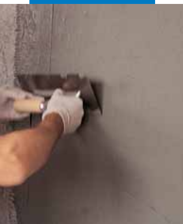
Applicazione di Planitop 540 con spatola metallica
