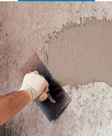
Applicazione di Planitop 540 con spatola metallica
