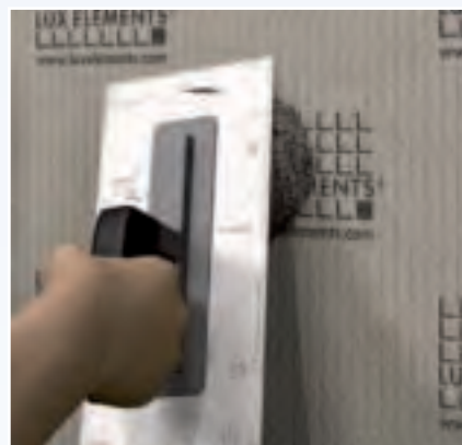
Cortar o material de suporte da espuma rígida com uma faca, raspar a espuma rígida para fora, encher com COL-AK, fixar posteriormente o conjunto de fixação na COL-AK.
