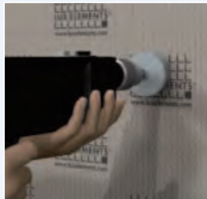
Abrir um furo no painel ELEMENT com uma broca de coroa.
