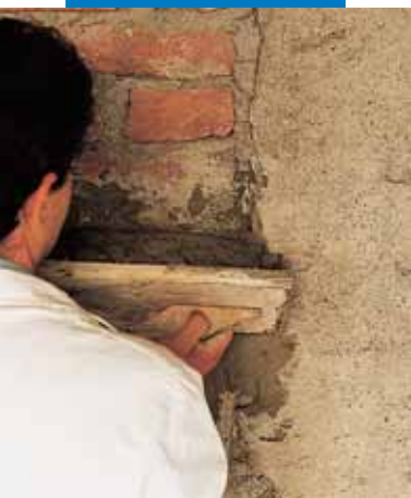
Restauro de alvenaria antiga
