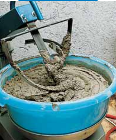
Mistura com mini-betoneira
