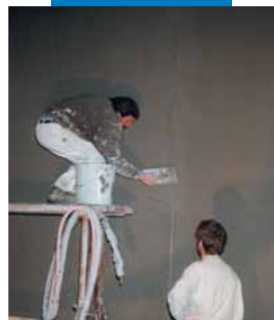
Nivelamento com talocha
