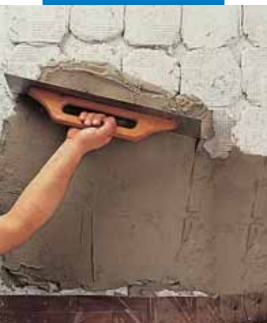
Nivelamento com talocha
