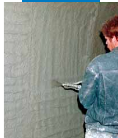
Aplicação de Nivoplan por projecção
