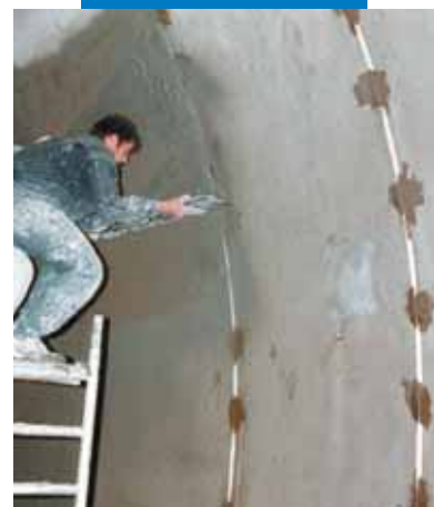
Regularização do reboco
