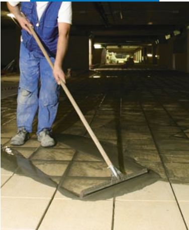
Applicazione a racla di Maxifuga
