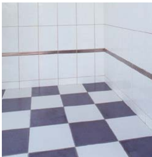
Pareti e pavimento posati con Mapetex System
