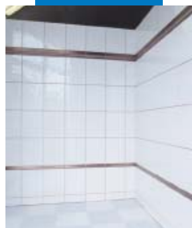
Parete già posata su Mapetex; Mapetex a pavimento pronto per la posa delle piastrelle
