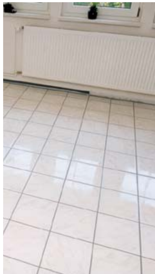
Pavimento removibile grazie a Mapetex System
