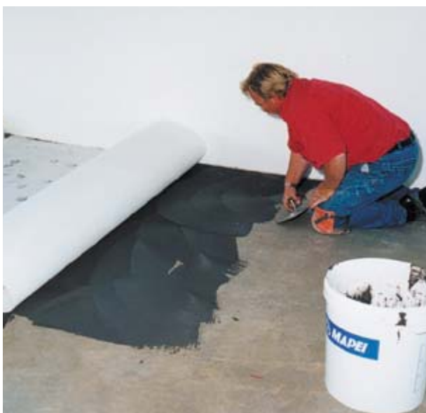
Mapetex può essere usato quale strato di desolidarizzazione per un pavimento ceramico su calcestruzzo non sufficientemente asciutto o stagionato
