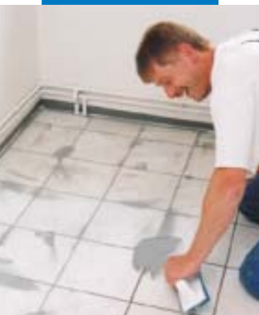
Stuccatura del rivestimento con Ultracolor
