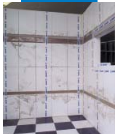
Posa di Mapetex-Strip su pareti di una sala mostra
