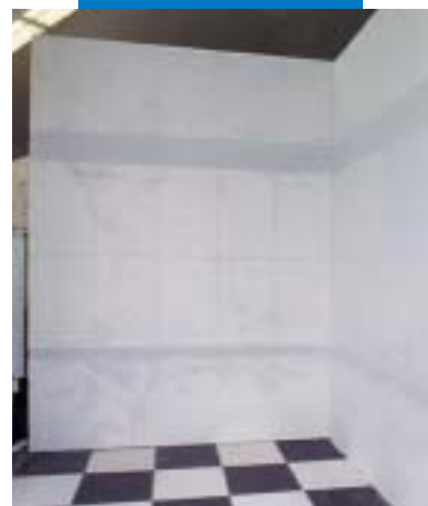
Fissaggio del Mapetex su Mapetex-Strip per il rivestimento di pareti
