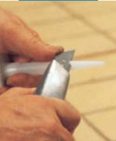
Cortar o injector de acordo com o tamanho da junta
