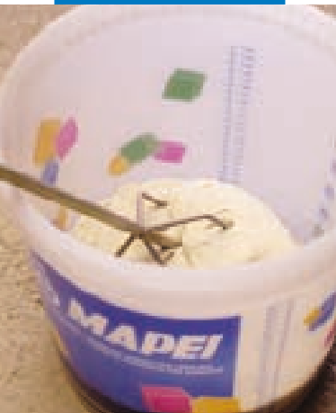
Mezcla de Mapeset con agitador mecánico
