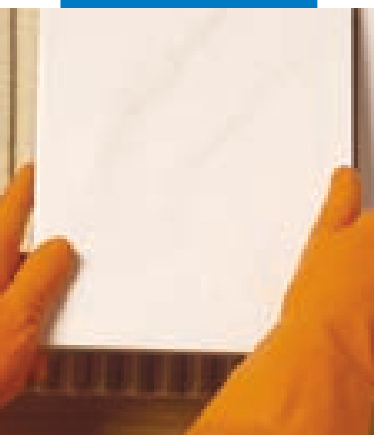
Colocación en pared de revestimiento cerámico
