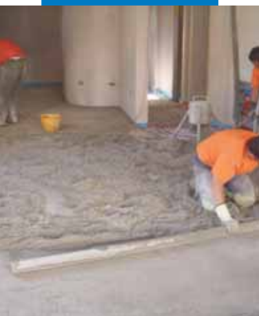
Stesura dell'impasto ottenuto con Mapescreed 704
