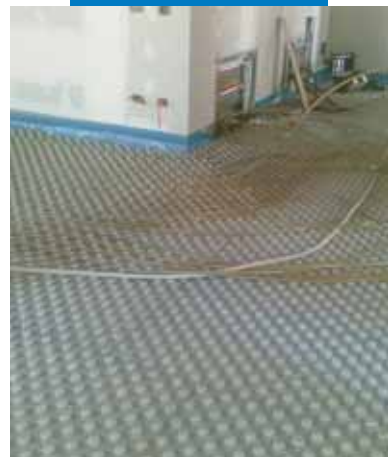
Preparazione dell'impianto radiante a pavimento
