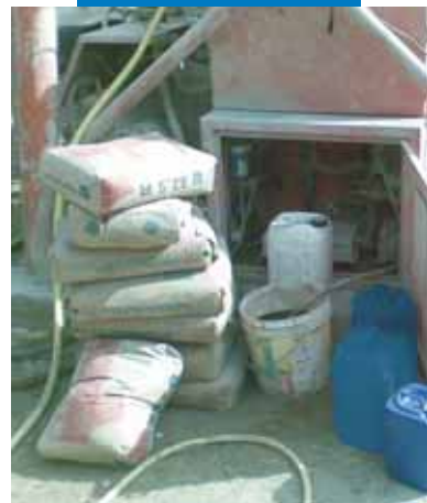
Sistema meccanizzato per il dosaggio di Mapescreed 704
