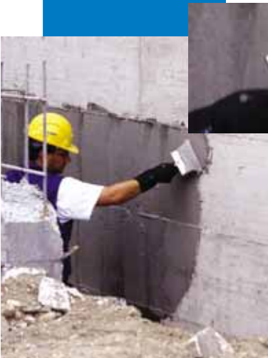
Impermeabilização de muro de fundação a pincel
