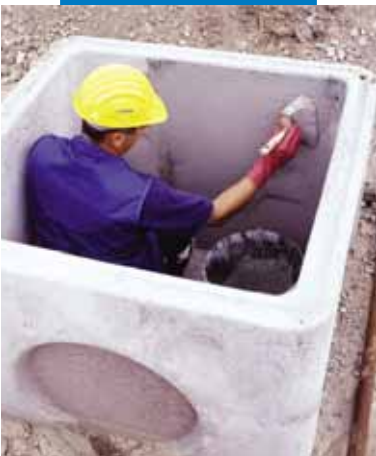
Impermeabilização de poço colector em cimento a pincel
