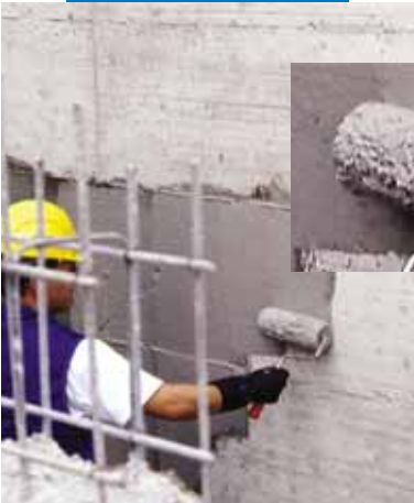
Impermeabilização de muro de fundação a rolo
