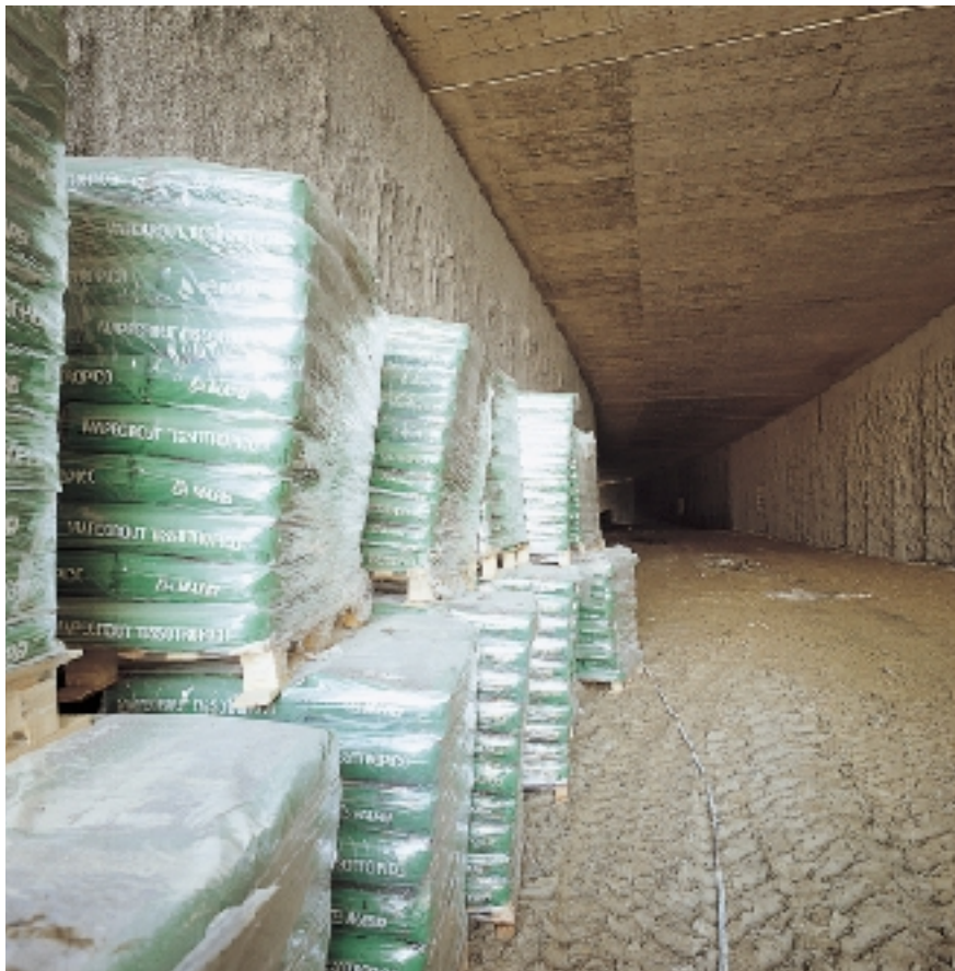
Regularização de diafragmas em galeria ferroviária
