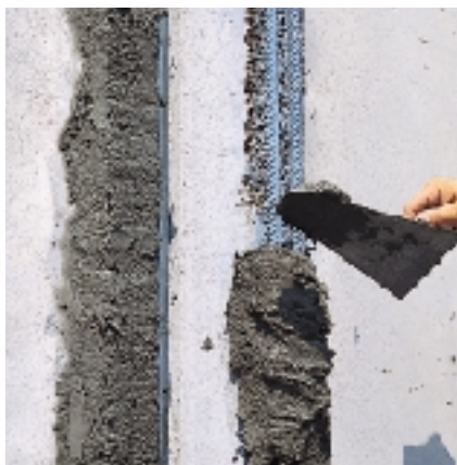
Aplicação com colher de pedreiro
