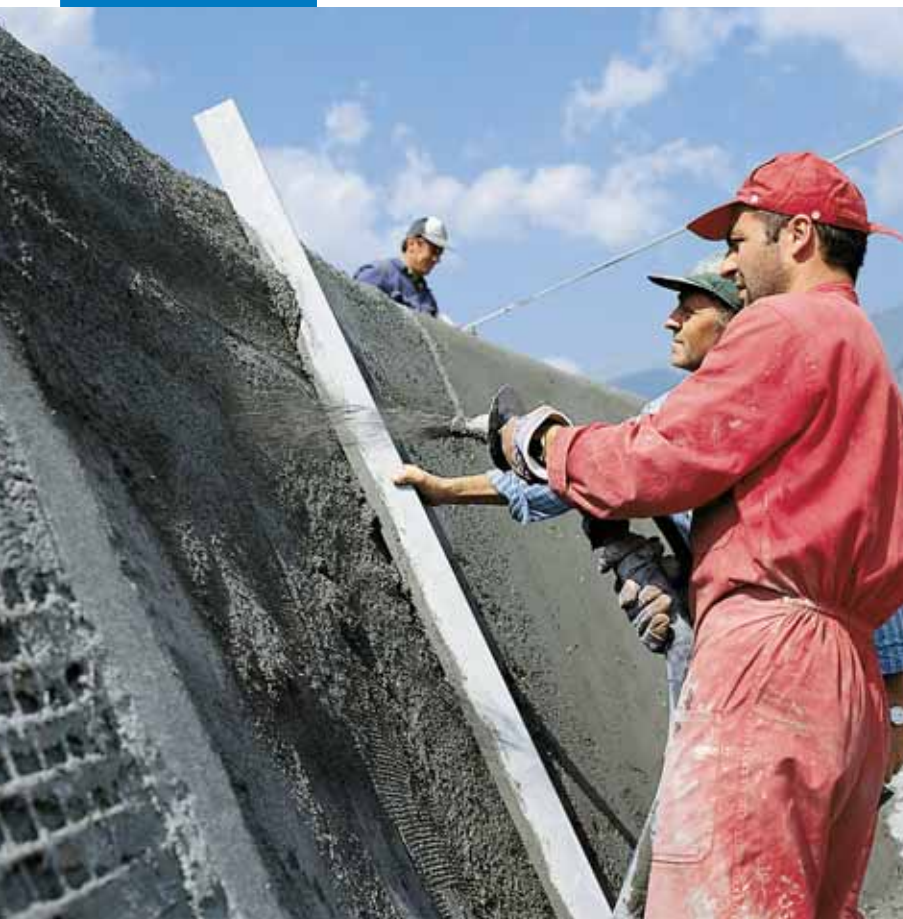
Aplicação de Mapegrout T40 com máquina de projectar reboco
