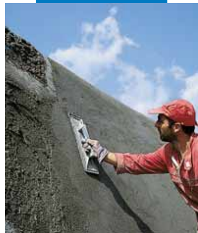
Acabamento do Mapegrout T40 com talocha
