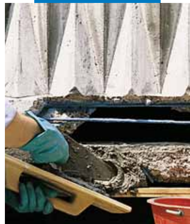
Exemplo de reparação de uma varanda com Mapegrout T40 “fase inicial”
