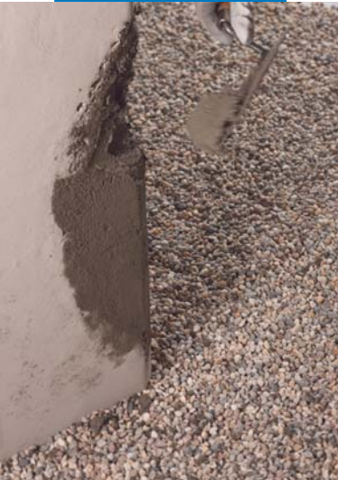
Applicazione a cazzuola di Mapegrout LM2K
