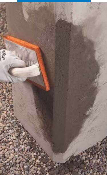
Frattazzatura di Mapegrout LM2K
