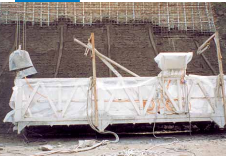
Particolare di una superficie in cls in fase di ripristino
