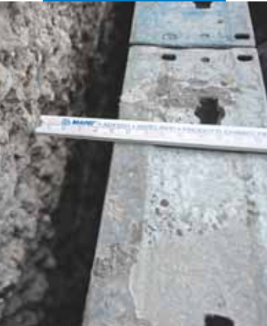
Posizionamento dei casseri a tenuta dopo adeguata preparazione del supporto
