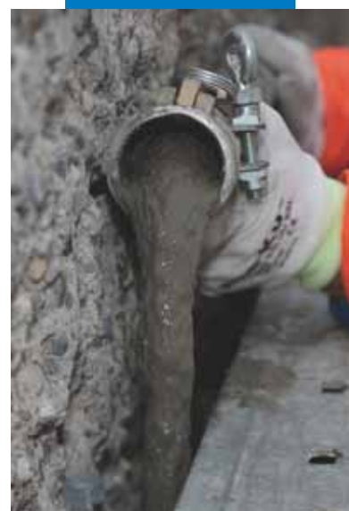
Messa in opera di Mapegrout Colabile GF
