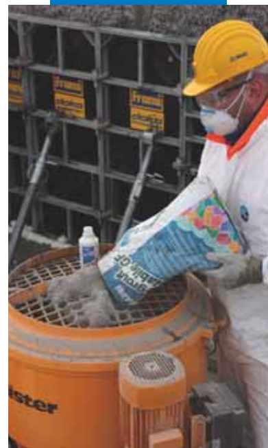
Preparazione di Mapegrout Colabile GF con l'aggiunta di Mapecure SRA
