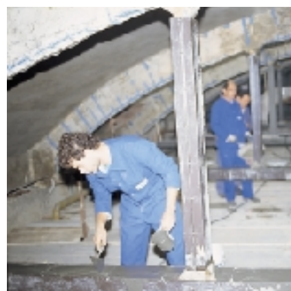
Colocação do MAPEGROUT COLABILE em cofragem metálica
