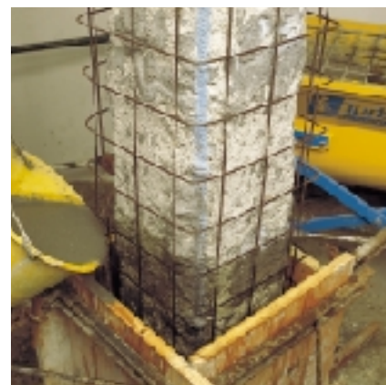
Colocação em cofragem
