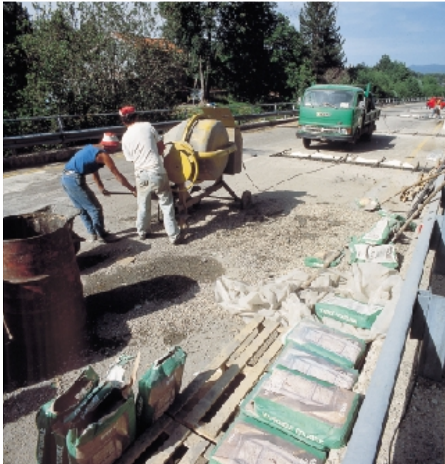
Renovação de juntas estradam
