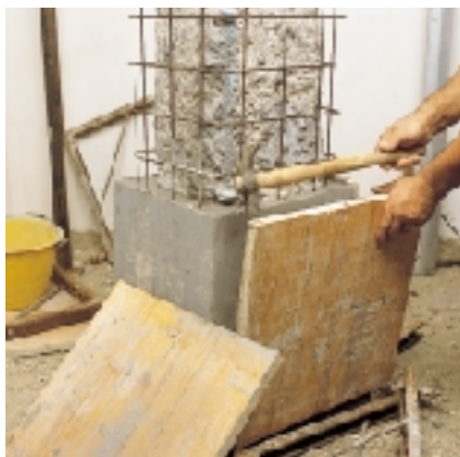
Desmontagem de cofragem em madeira
