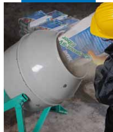
Preparação da mistura de Mapegrout SV Fiber
