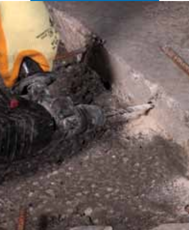
Preparação dos furos para a inserção dos ferros (de ancoragem)
