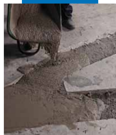
Aplicação de Mapegrout SV Fiber na zona a reparar
