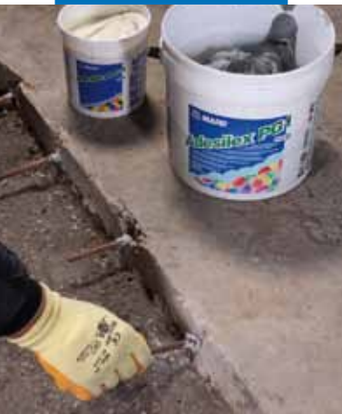
Fixação dos ferros para a ancoragem com Adesilex PG1
