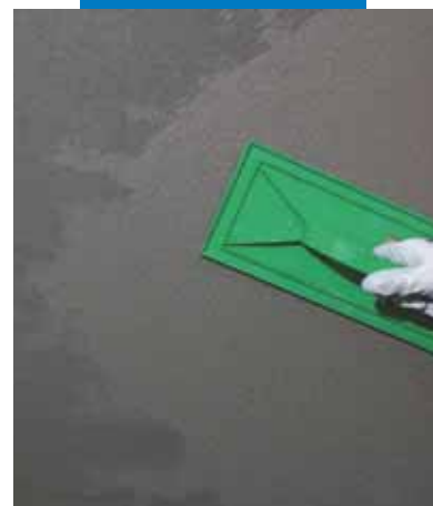
Afagamento à talocha do Mapegrout 430
