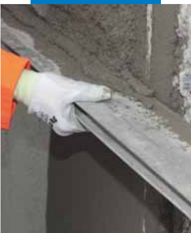
Nivelar à régua do Mapegrout 430
