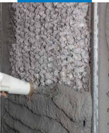
Aplicação com máquina de projetar do Mapegrout 430
