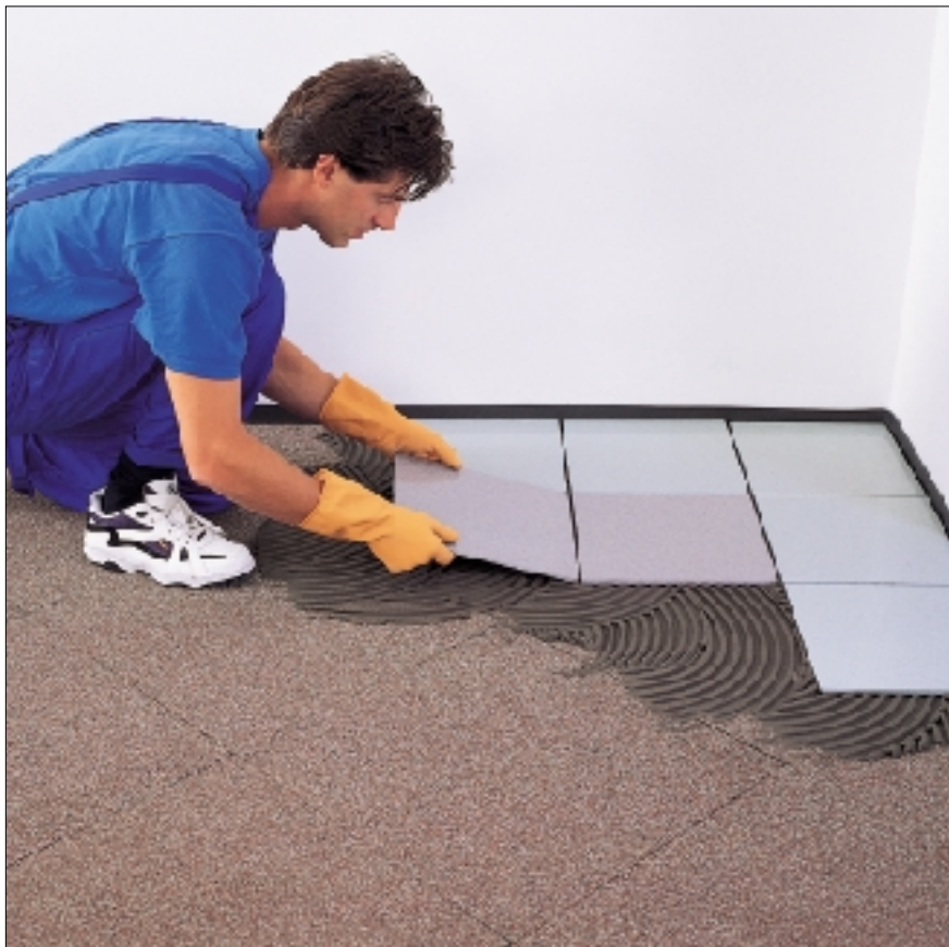
Assentamento de ladrilhos de grès porcelânico polido
