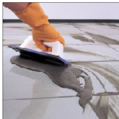
Estucagem das juntas com MAPEFONIC GROUT
