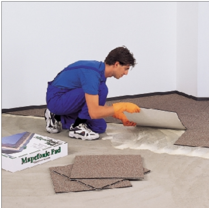
Aplicação de MAPEFONIC PAD
