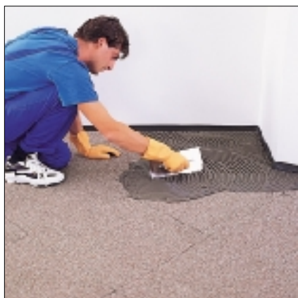
Aplicação de MAPEFONIC MORTAR sobre MAPEFONIC PAD
