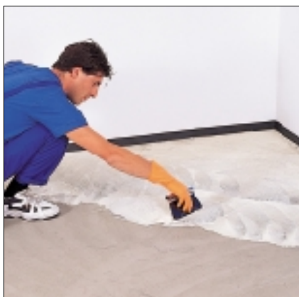
Aplicação de MAPEFONIC GLUE com espátula dentada
