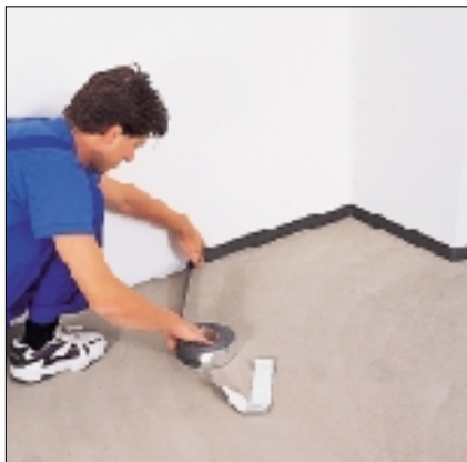
Aplicação de MAPEFONIC STRIP ao longo do perímetro do local
