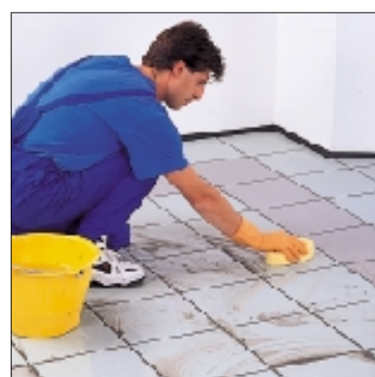
Limpeza da pavimentação com esponja húmida
