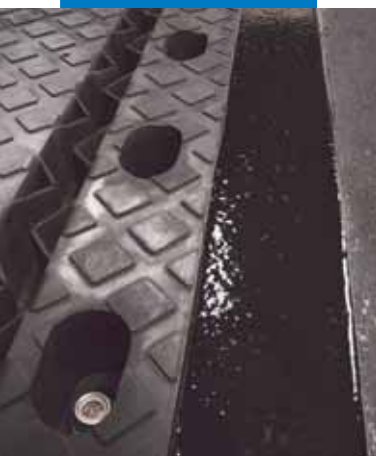
Giunto di transizione sigillato con Mapeflex PU65 caricato con sabbia
