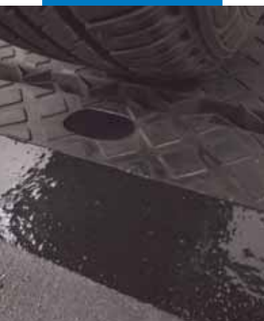
Mapeflex PU65 polimerizzato, pronto per il transito
