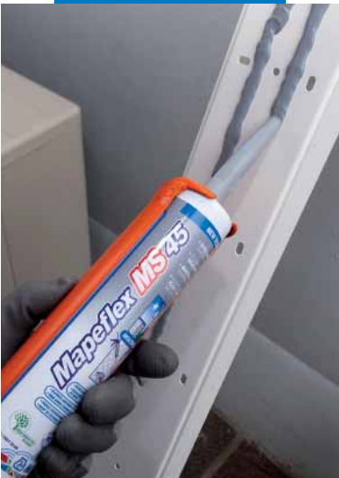
Incollaggio di profili in plastica in esterno
