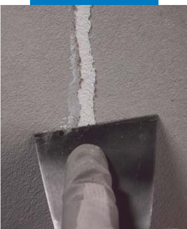
Lisciatura superficiale con spatola
