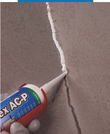
Estrusione di Mapeflex AC-P nel giunto
