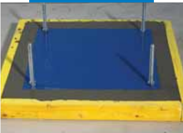
Inghisaggio ultimato dei tirafondi con Mapefill R
