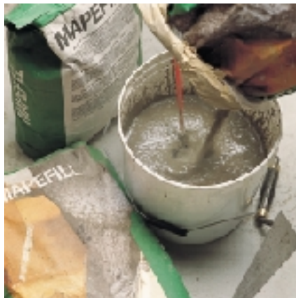
Massa de MAPEFILL com água
