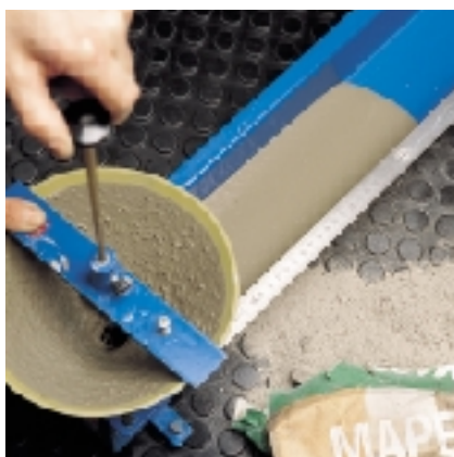
Teste de derramamento em canal de adução segundo a norma UNI 8997/89
