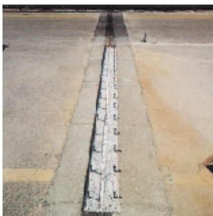
Restabelecimento de junta de ponte de auto-estrada com MAPEFILL
