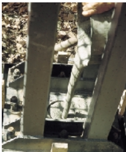
Aplicação de ferro fundido com MAPEFILL
