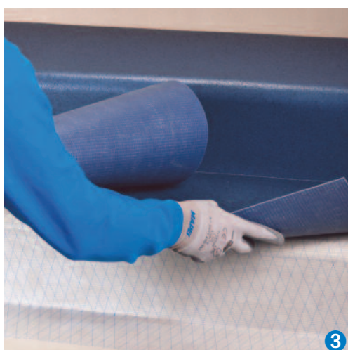
Posa di PVC su gradini mediante utilizzo di Mapecontact
