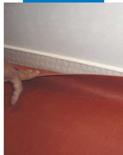
Realizzazione di sguscia mediante utilizzo di Mapecontact
