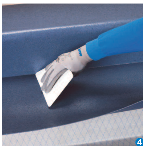
Massaggiatura del PVC dopo applicazione su Mapecontact
