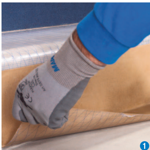
Posizionamento di Mapecontact sulla alzata del gradino
