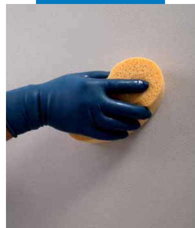
Rifinitura con spugna di Mape-Antique FC Civile
