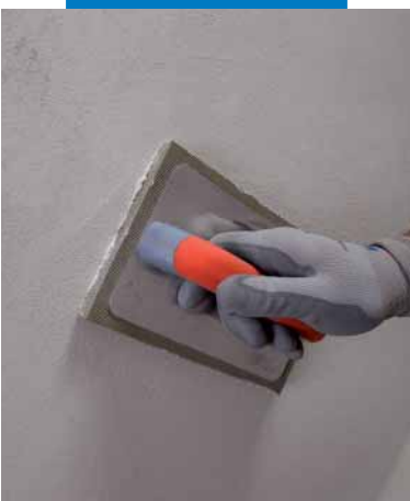
Rifinitura con frattazzino di spugna di Mape-Antique FC Civile
