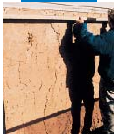
Acabamento de reboco com Mape-Antique CC
