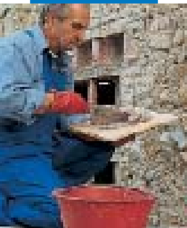
Aplicação da argamassa de Mape-Antique CC com colher de pedreiro
