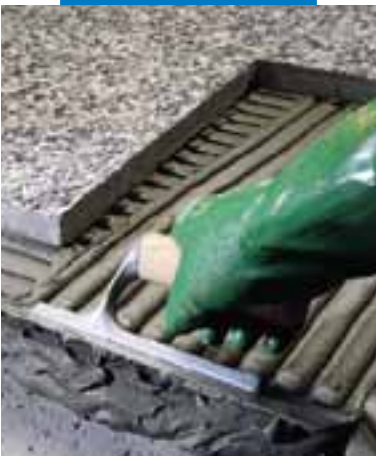
Colocación de baldosas con cemento de mármol de relieve con granalla en exteriores
