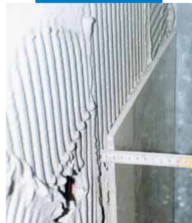
Colocación a espesor de baldosas cerámicas en pared
