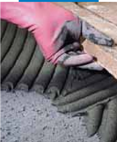
Colocación de terracotta hecha a mano sobre solera irregular
