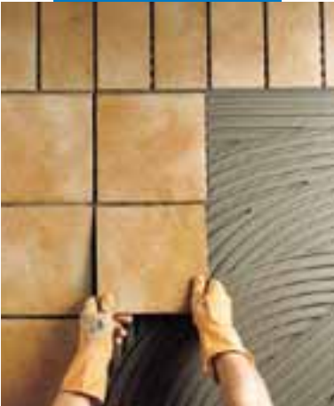
Colocación de klinker en exteriores
