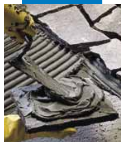
Colocación de piedra de rotura en exteriores con o sin aplicación según el espesor
