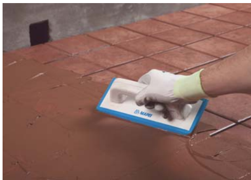
11. Dopo aver applicato il prodotto impermeabilizzante MAPEI secondo le indicazioni contenute nella relativa Scheda Tecnica, incollare la pavimentazione ed infine, stuccare le fughe
