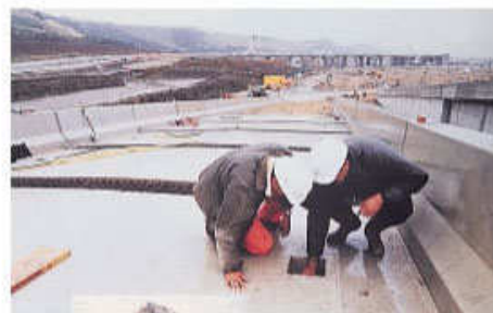
Connettori Staifix nelle rampe di accesso al cavalcavia dell' EuroTunnel
