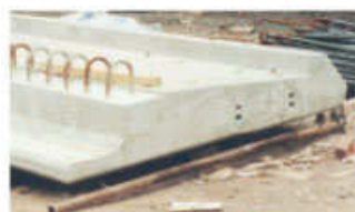
Utilizzo dei Connettori Staifix in parapetti prefabbricati
