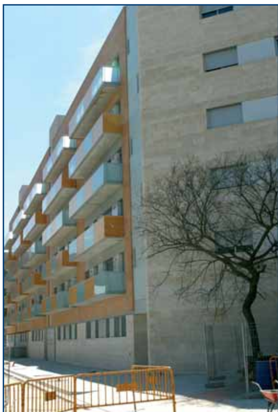
Edifício na Vila Olímpica (BCN) Aplicação de 2.800 m 2 de Mármore Caramiel com Ardex X701+Ardex S33.
