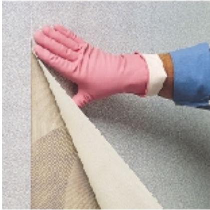
Colocación de las piezas
