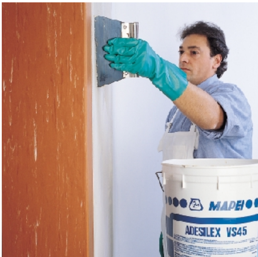
Aplicación del adhesivo después de la colocación de la pieza de PVC vuelta sobre la esquina
