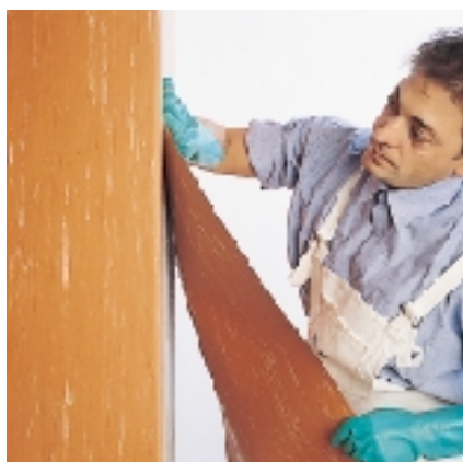
Colocación de la tela siguiente
