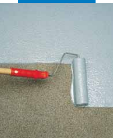
Aplicação de Mapecoat I 24 com rolo
