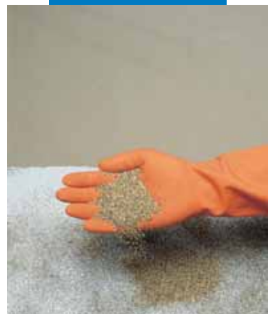
Pulverização de areia enxuta sobre Mapecoat I 24 fresco
