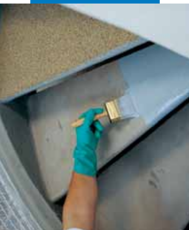
Aplicação de Mapecoat I 24 sobre betão
